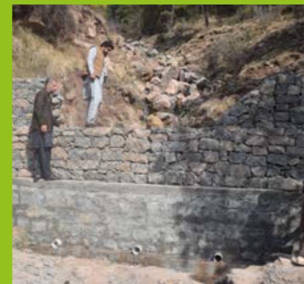
Una de las presas que construimos en Azad Jammu y Cachemira para proteger mejor los hogares y los medios de vida.
