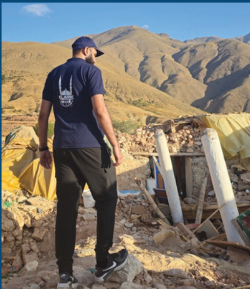
Hassan Ghani Sheikh, de Islamic Relief, observando los escombros de las casas en ruinas en la aldea de Tagadirt, Chichaoua, Marruecos
